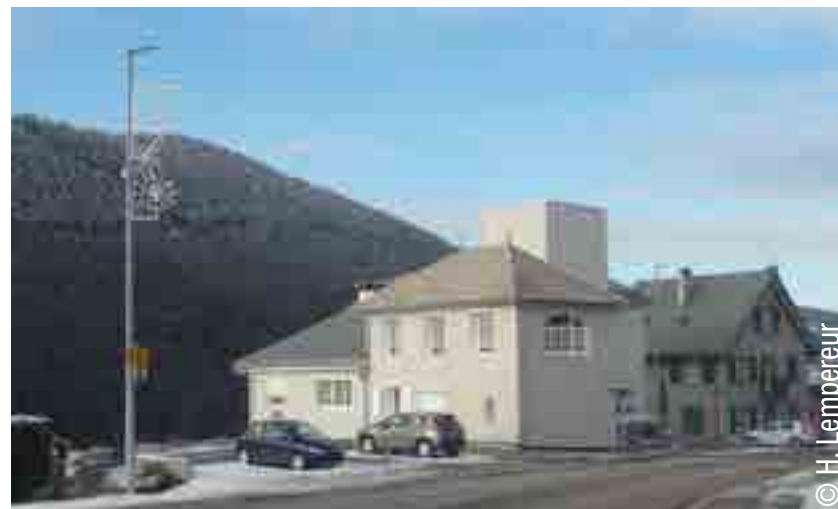
↑ Exemples d'Isolation Thermique par l'Extérieure (ITE) Villard-de-Lans 2019/2020
