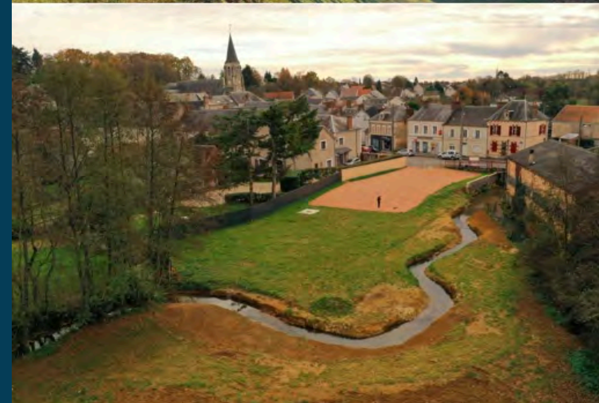
Reconversion d'une friche industrielle et renaturation de l'Auxigny à Saint-Martin - Source : Syndicat Intercommunal de la Vallée de l'Yèvre
