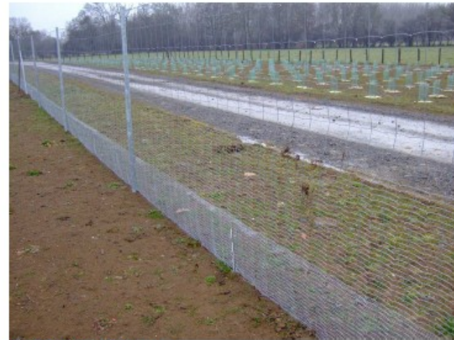
Crédit photo : Cerema Clôture spécifique le long d'une infrastructure routière
