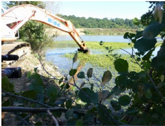
Crédit photo : UNICEM Entreprises engagées Restauration / réhabilitation de milieu par enlèvement d'espèces exotiques envahissantes
