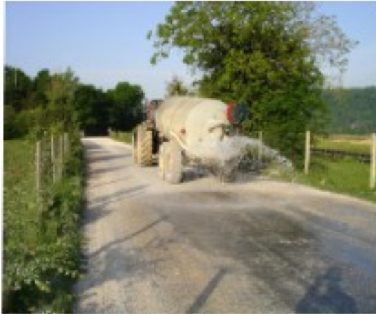
Crédit photo : GSM Dispositif de limitation des nuisances par arrosage limitant l'envol des poussières
