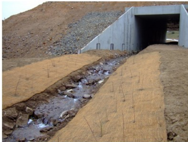
Crédit photo : Cerema Aménagement paysager d'accompagnement dans les emprises du projet
