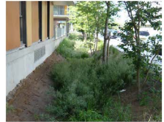
FOSSE D'INFILTRATION AU PIED D'UN BÂTIMENT
